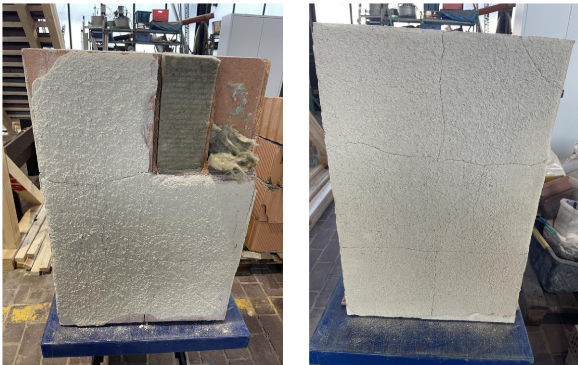
Abbildung 1: Brandseite der Mauerwerkskörper mit Großkammer Ziegel links und Kleinkammer Ziegel rechts nach 90 min ETK
